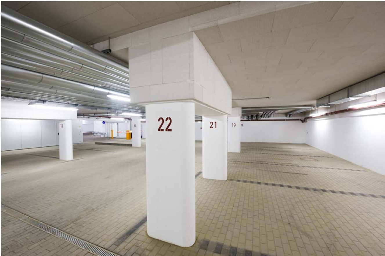
Плочите Multipor са най-добрата топлоизолация за помещения, намиращи се над гаражи, закрити паркинги и проходи към тях
