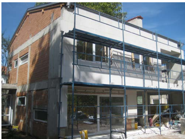
Допълнителна външна топлоизолация с плочи Multipor на къща, изградена с керамични тухли (с. Кътмина)
